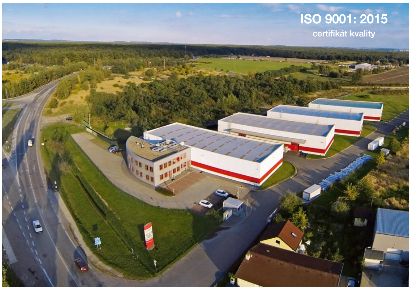
Logistický areál ELEKTRODESIGN ventilátory s.r.o. ve Staré Boleslavi v prostoru mezi dálnicí E65/D10 a vnitřní komunikací do Staré Boleslavi.
